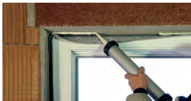
Primer vgradnje: ISO-TOP FLEX LEPILO SP
