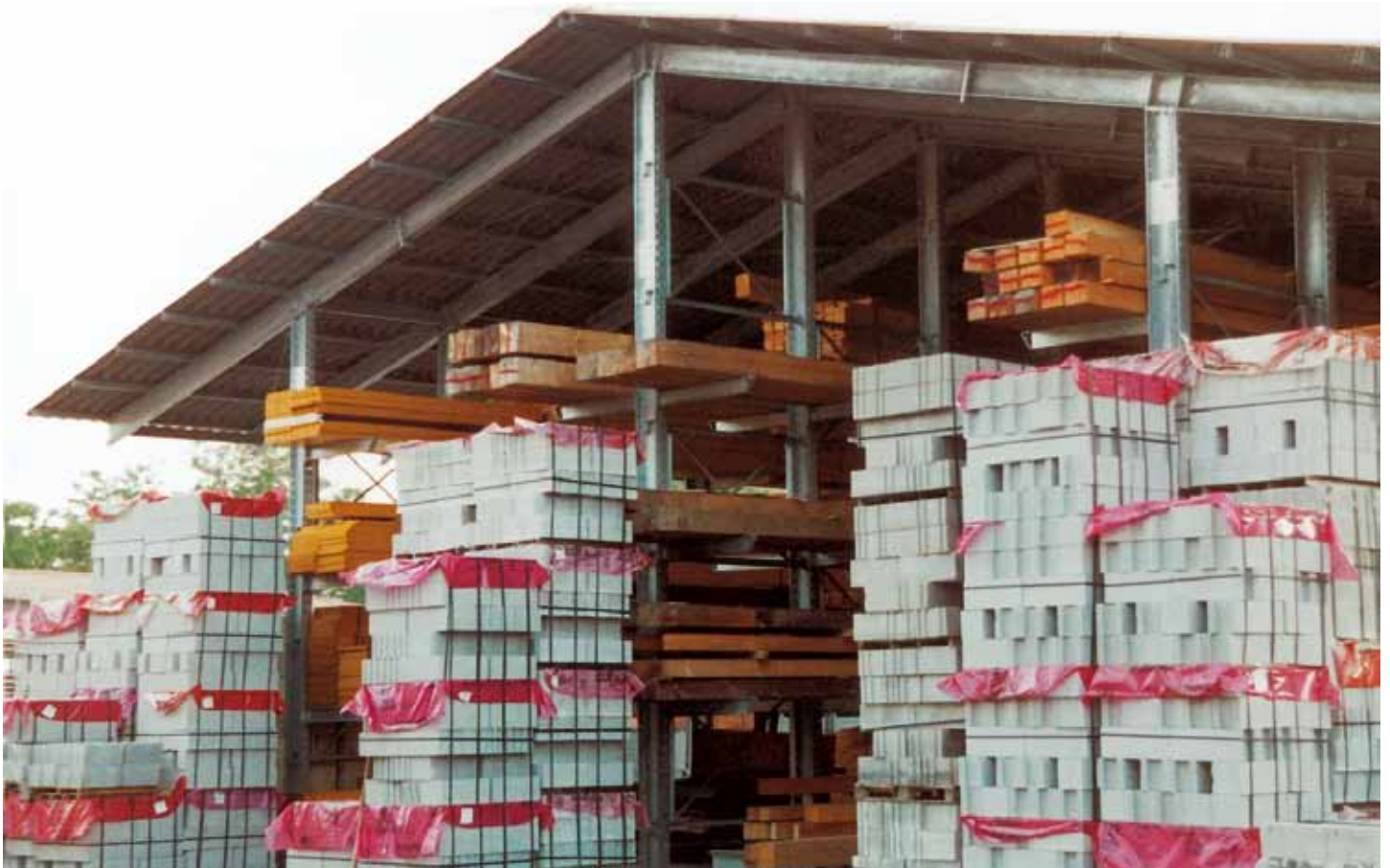
Magazzino Cantilever coperto autoportante a 2 falde
