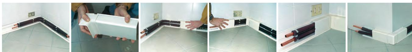
Posizionamento delle tubazioni ed assemblaggio del raccordo angolare con il profilo. Tramite l'apposita chiusura ad incastro dei due profili è possibile eseguire un facile completamento dell'impianto.
